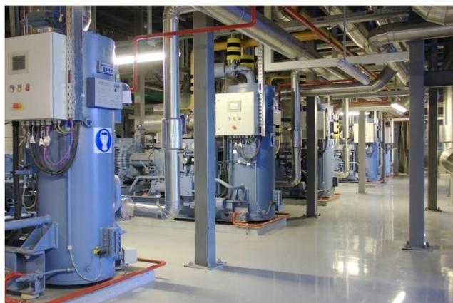
Рисунок 2 – Винтовые компрессорные агрегаты GEAGrasso
