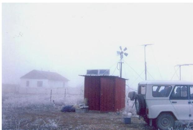
Рисунок 4 - Телеметрическая станция, оснащенная гибридной системой солнце-ветер
