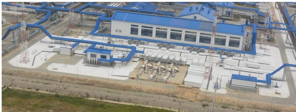
Рисунок 5 – Солнцезащитные навесы и белый щебень на противофильтрационной пленке на площадках технологических трубопроводов на НПС-14 МН ВСТО-1
