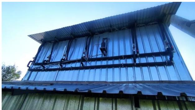
Рисунок 5 – Радиаторы и их распределительные коллекторы экспериментальной установки
