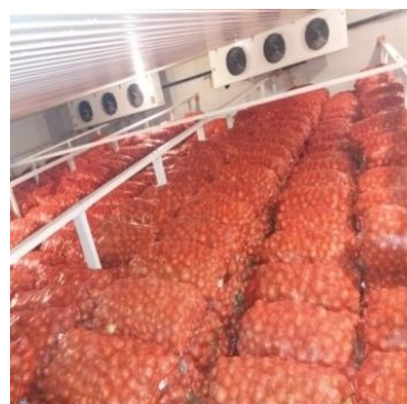
Рисунок 2– Размещение лука в мешках и воздухоохладителей в охлаждаемом помещении овощехранилища ТОО «Бирлик-4»: а) – вид сбоку, б) – вид сверху
