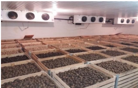
Рисунок 1– Размещение картофеля в контейнерах и воздухоохладителей в охлаждаемом помещении овощехранилища ТОО «Бирлик - 4»
