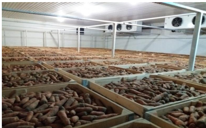
Рисунок 3–Размещение моркови в контейнерах и воздухоохладителей в охлаждаемом помещении овощехранилища ТОО «Бирлик-4»
